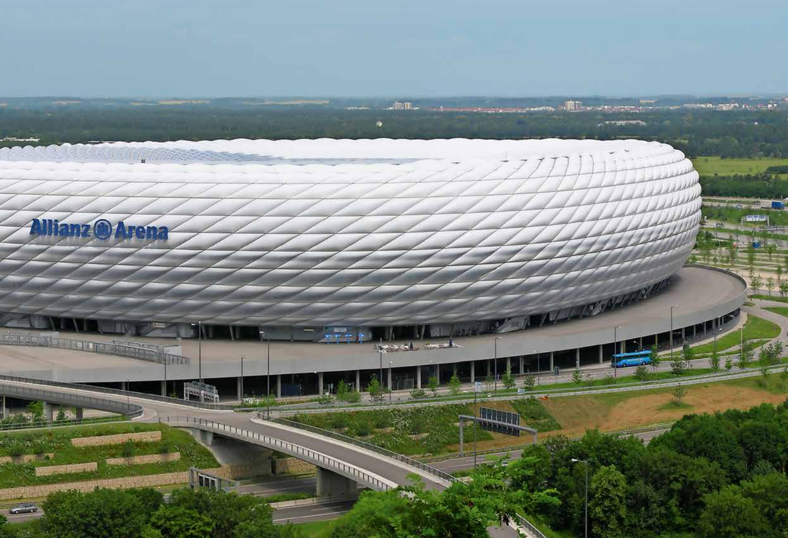
Die Allianz Arena, Spielstätte von Bayern München, ist von einem Zaun mit Personenschleusen umgeben.
